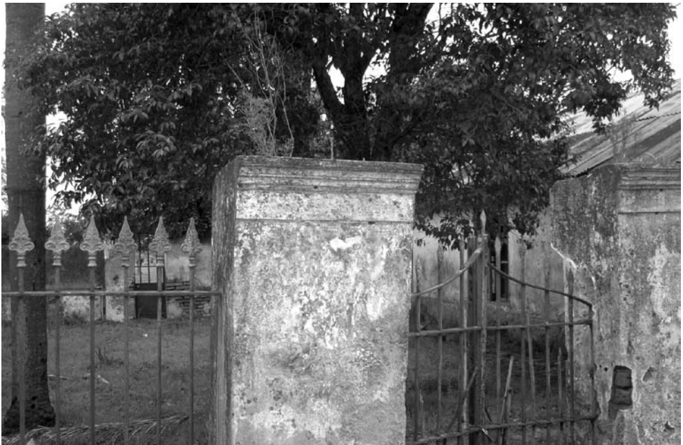
Entrada a la casa de los Trelles en Tala
