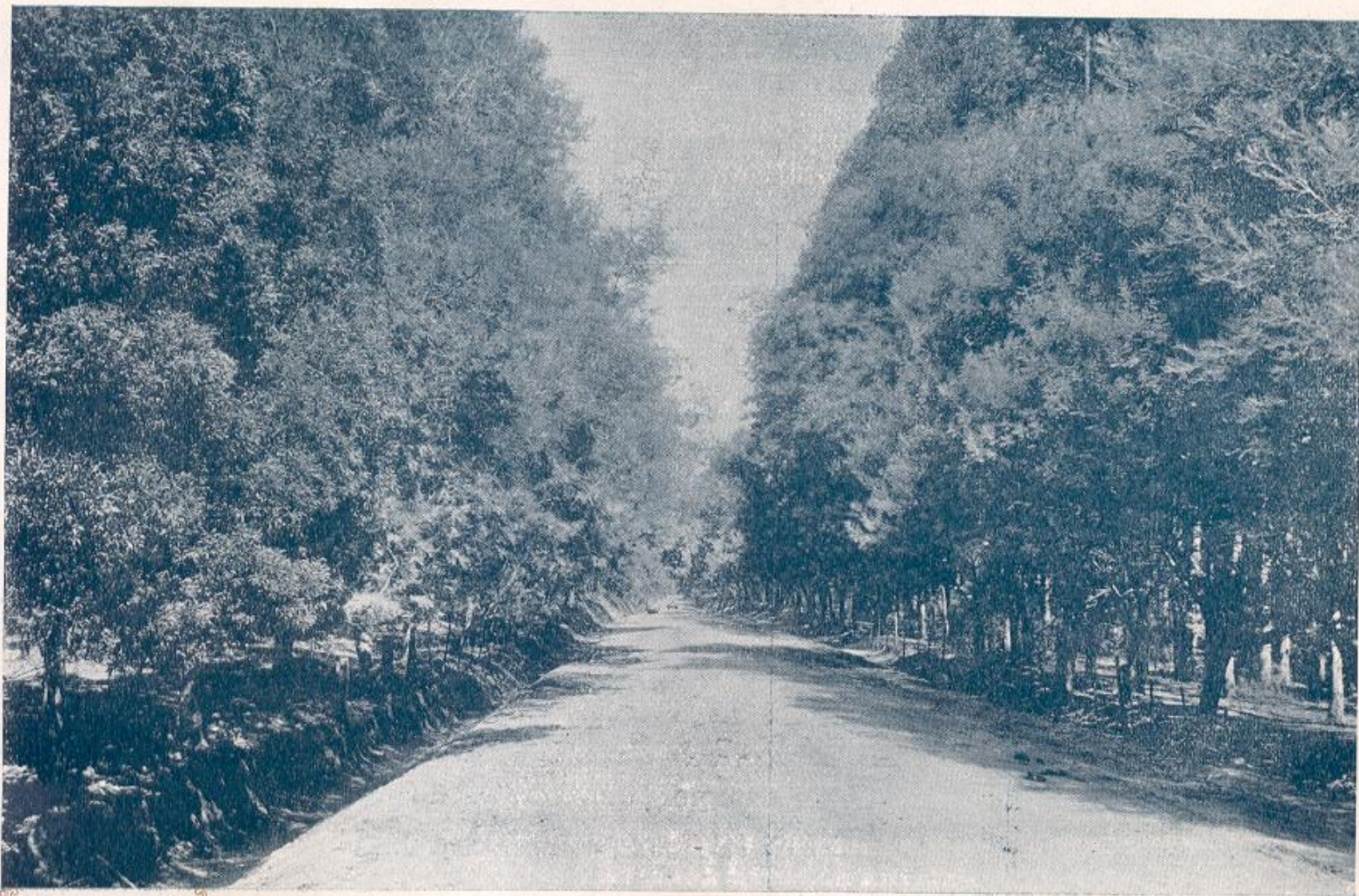
AVENIDA GENERAL ARTIGAS
