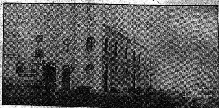
Edificio de la oficialidad y tropa, construido por la marinería
